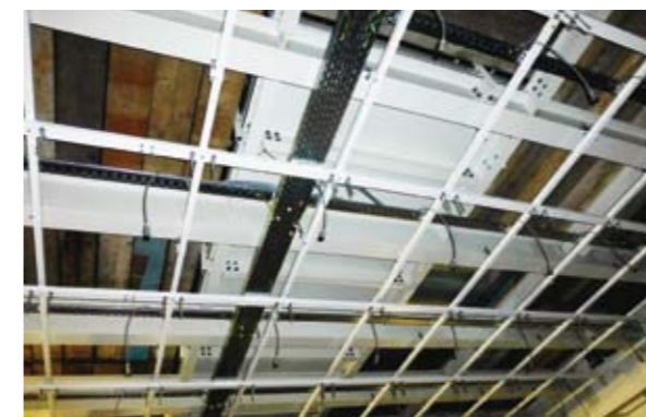
Montage einer Anlage mit 117 Leuchtmodulen auf 4 m Höhe
